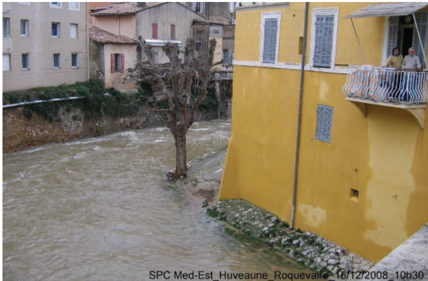
Figure 64 : Photos des PHE 2008 à Roquevaire
